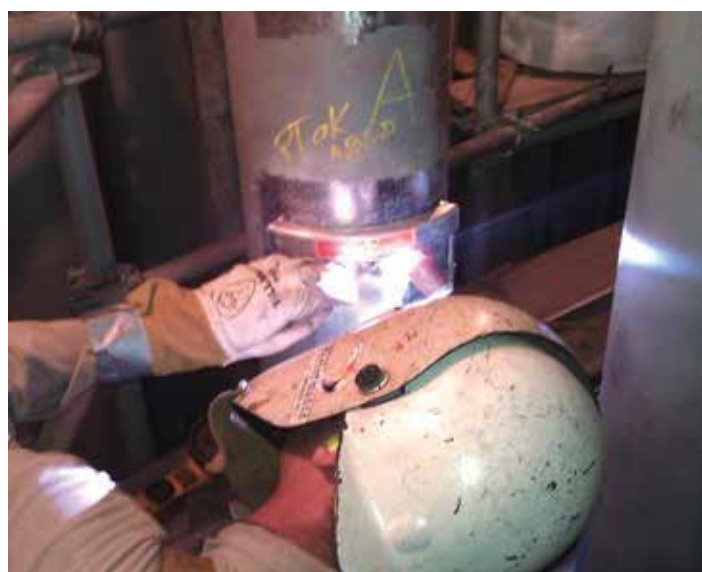
Квалифицированный специалист, выполняющий монтаж термомпары для измерения температуры поверхности трубы
